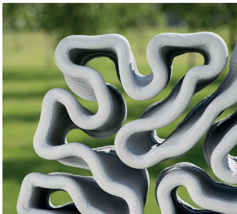
Exemple d'ouvrage réalisé en impression 3D béton.
